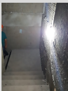
Figura 4.37 – Iluminação baixa em local de circulação de pessoas
