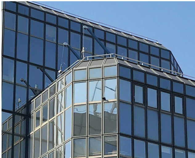
(b) Guinchos na cobertura do edifício
