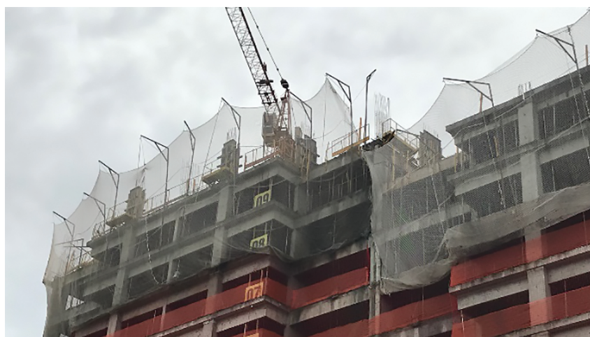
Figura 3.30 – Sistema limitador de quedas de altura
