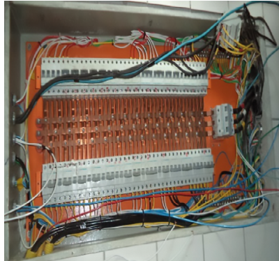
Figura 4.4 – Circuito de Distribuição
