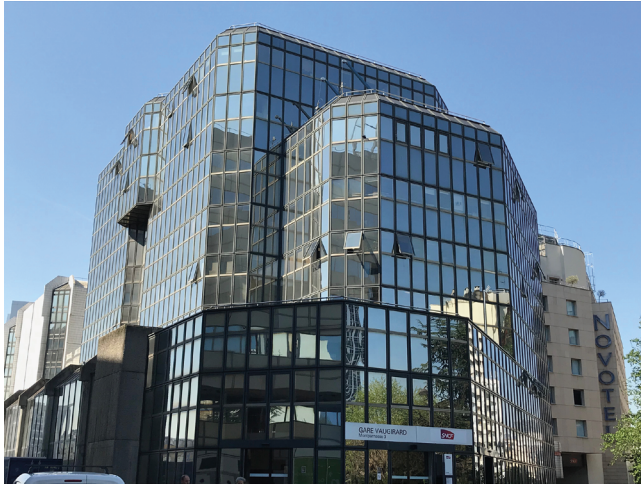
(a) Edificação com fachada de vidro
