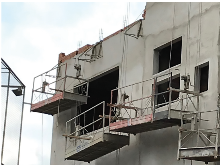
Figura 1.2 – Andaimos suspensos fixados na estrutura da edificação com emprego de afastadores metálicos e cabos de aço
