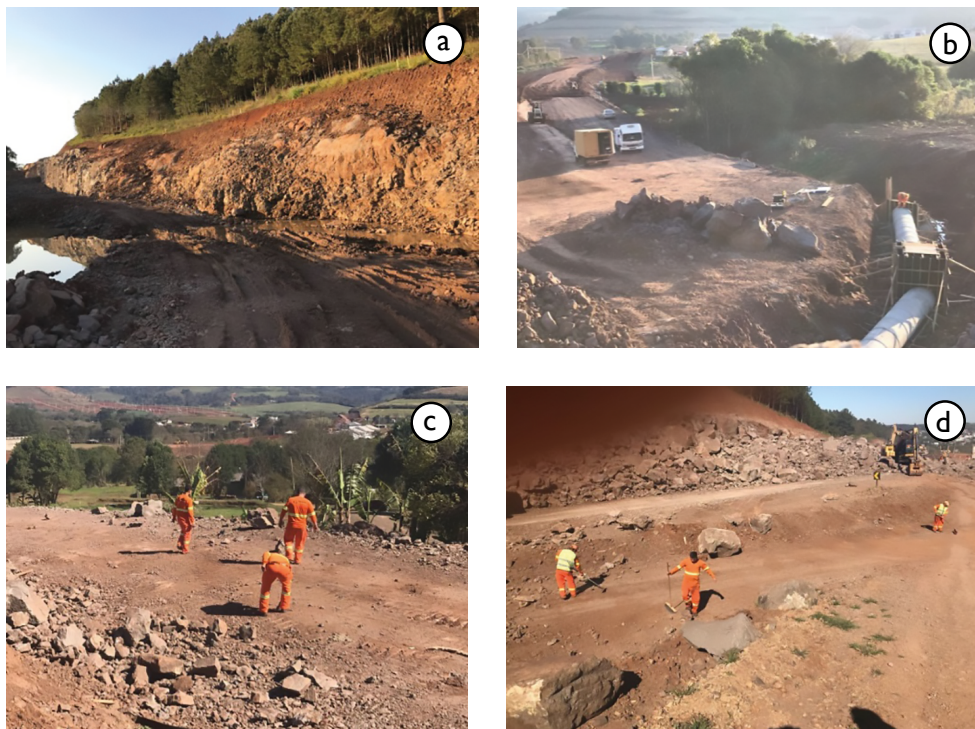
Figura 5.2 – Serviço manual e regularização do terreno; (a) (b) Preparação e aberturas das novas estradas; (c) (d) Trabalhador executando a limpeza e desobstrução das vias
