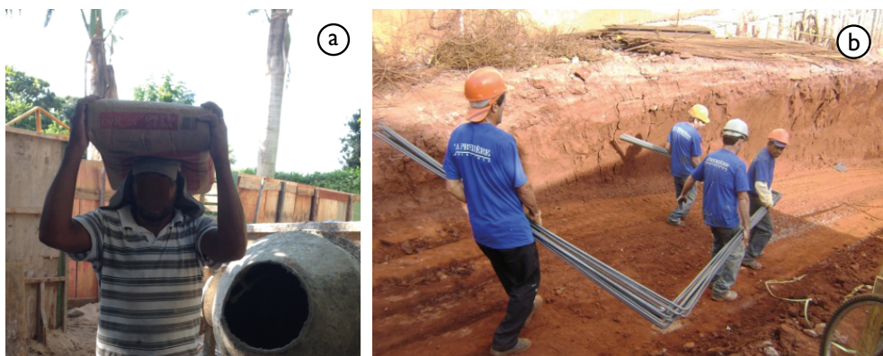
Figura 6.8 – Transporte e manuseio de cargas
