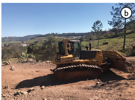
Figura 5.3 – Atividade de movimentações com maquinário (a) (b) limpeza para desobstrução da via após detonação de rocha; (c) descarregamento com utilização de caminhão basculante; (d) movimentações de terra com auxílio da escavadeira
