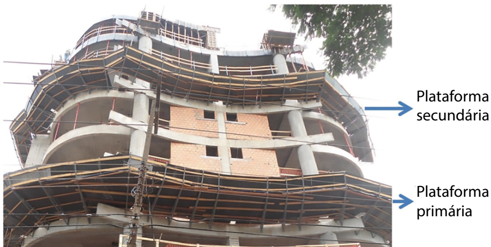
Figura 3.20 – Plataformas primária e secundária em utilização
