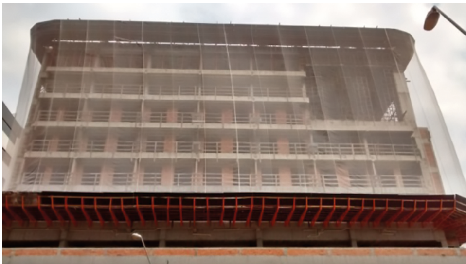
Figura 3.32 – Esquema da tela fachadeira nas plataformas
