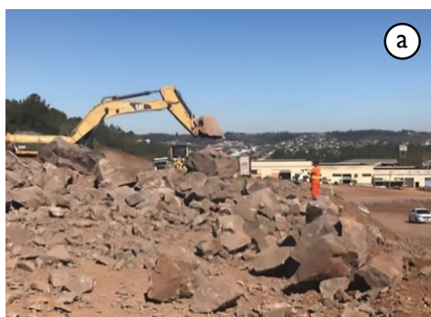
Figura 5.3 – Atividade de movimentações com maquinário (a) (b) limpeza para desobstrução da via após detonação de rocha; (c) descarregamento com utilização de caminhão basculante; (d) movimentações de terra com auxílio da escavadeira
