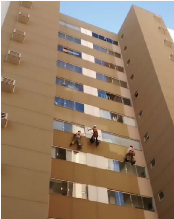
Figura 1.3 – Manutenção de fachada de edificação com funcionários em cadeiras suspensas por cordas ancoradas nos pontos de ancoragem da cobertura
